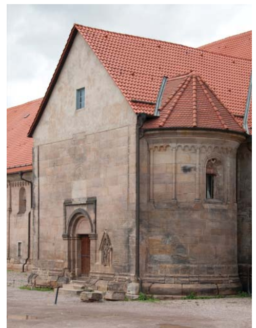
Südliches Querhaus mit Südportal (Foto: L. Götz)
